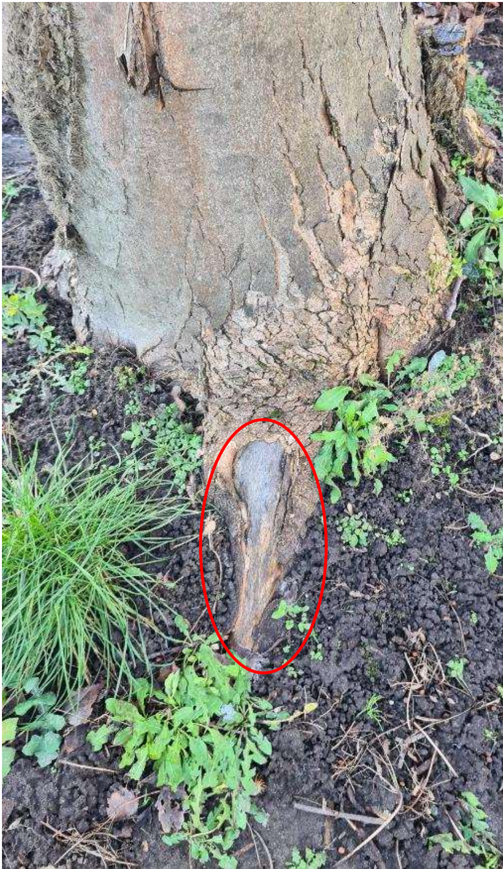
Rindenschaden 2 an Wurzelanlauf (Baum 1)
