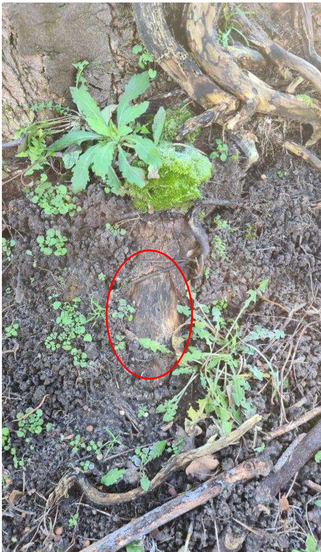
Rindenschaden 3 an Wurzelanlauf (Baum 1)
