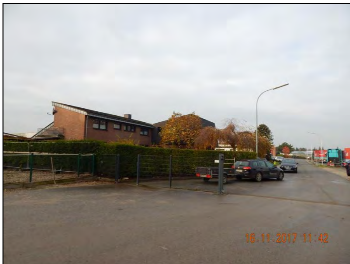
Abbildung 9: Als Büro genutzte Bebauung an der Industriestrasse
