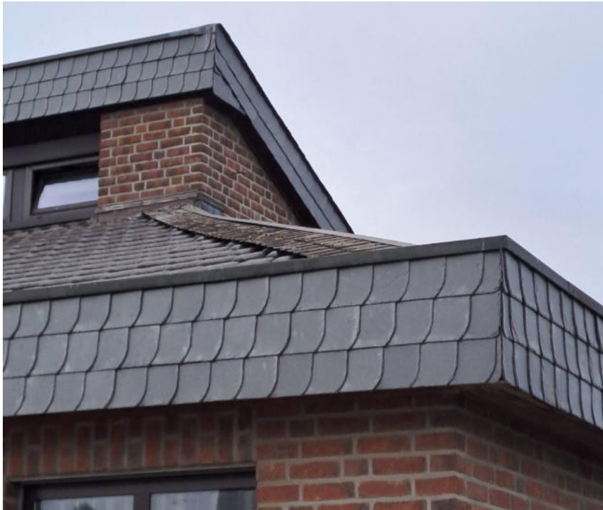
Bild 9: Randliche Dachverkleidungen aus Schieferschindeln (eigene Aufnahme, 22.08.2025)
