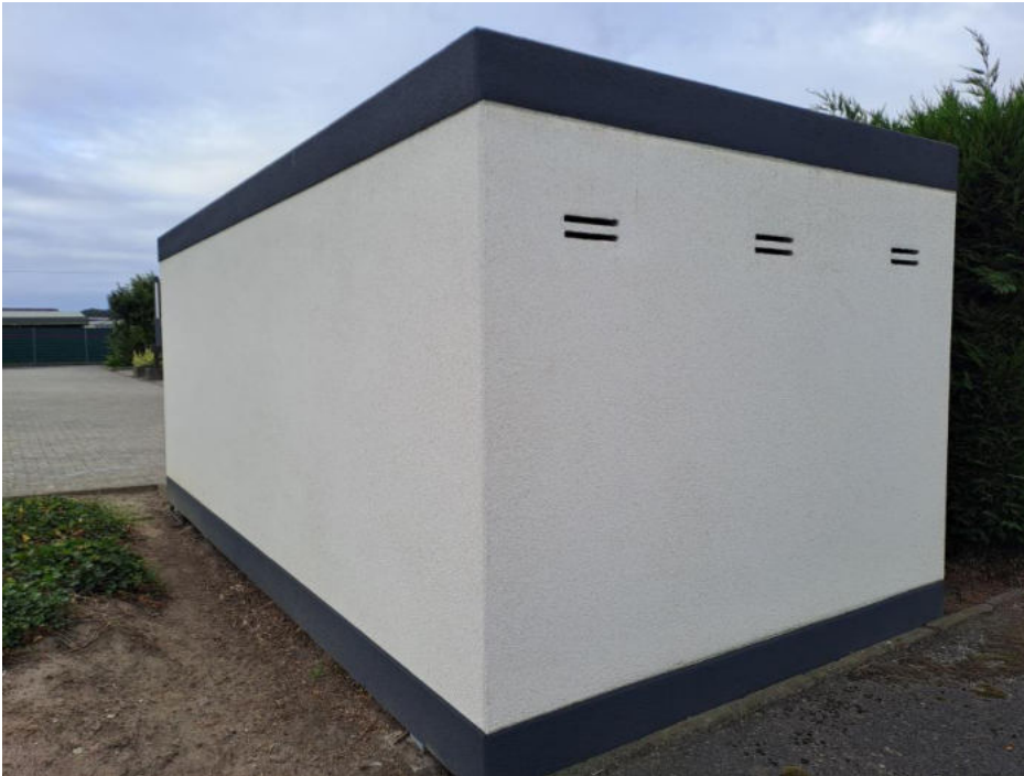
Bild 11: Rückseite der Garage mit Luftschlitzen (eigene Aufnahme, 22.08.2025)
