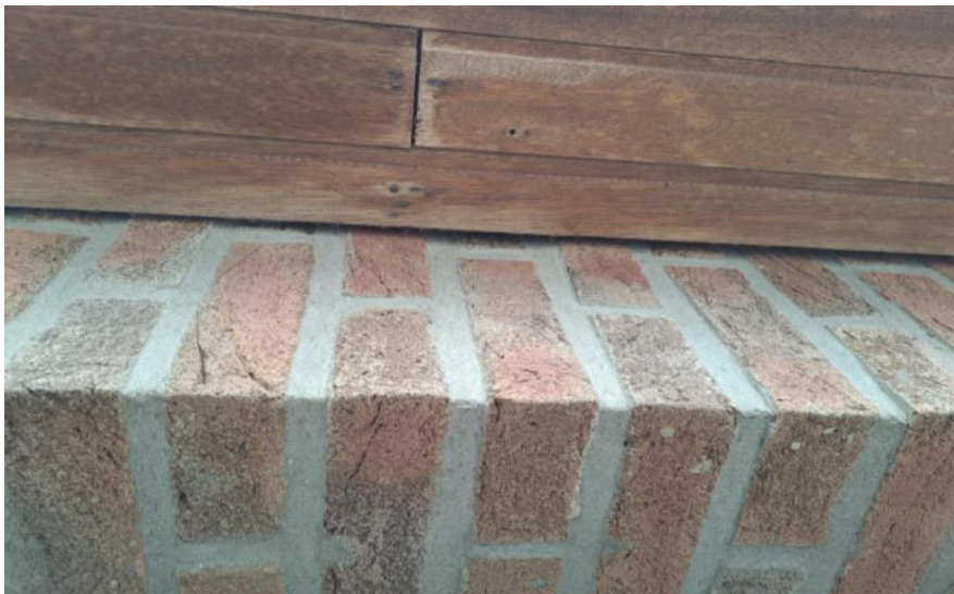
Bild 10: Breiterer Schlitz zwischen Wand und Unterseite des Dachüberstandes (eigene Aufnahme, 22.08.2025)
