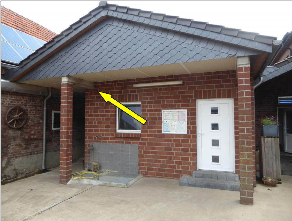
Abb. 3: Rauchschwabennest an einem Nebengebäude des Wohnhauses (24.06.2022)
