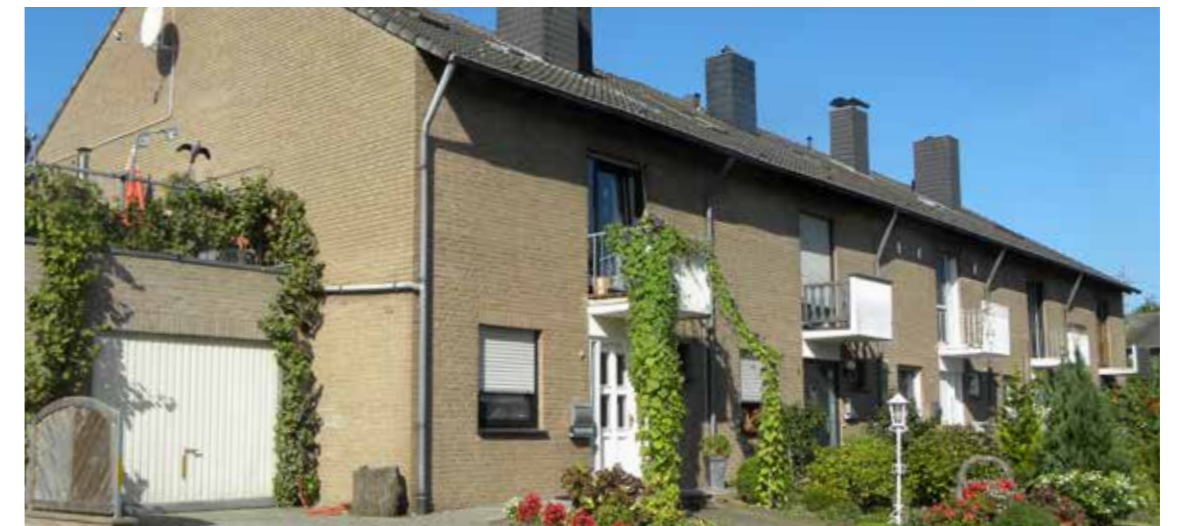
Reihenhäuser in der Vogelsiedlung mit separaten Heizungsanlagen
