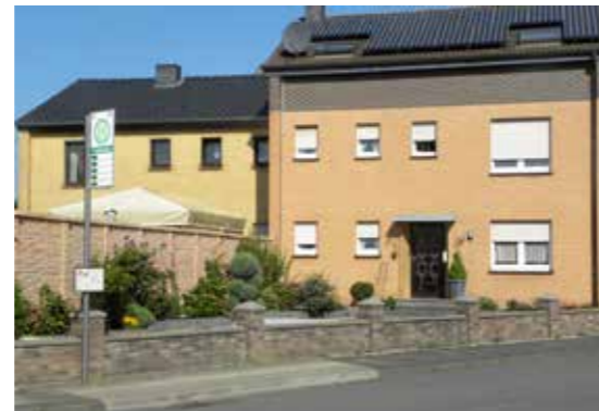
Eine Wohngebäude mit Solarthermie-Anlage in der Vogelsiedlung Straelen
