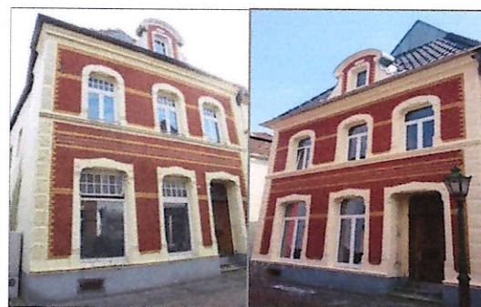
Abbildung 1 Vorher-Nachher Darstellung eines Förderobjektes des Hof- und Fassadenprogramms, Quelle: DSK GmbH 2018
