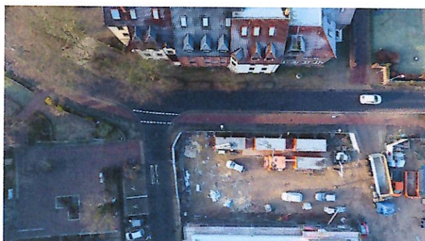
Abbildung 6 Ostwall vor der Baumaßnahme (Quelle: https://www.straelen.de/de/meldungen/ostwall-wieder-vollstaendig-fuer-den-verkehr-freigegeben/ )
