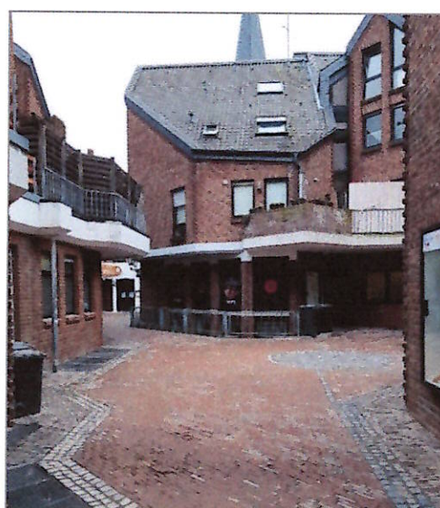
Abb. 1: Kleiner Markt nach dem Abriss des "Betonpilzes" (Quelle: DSK 2020)
