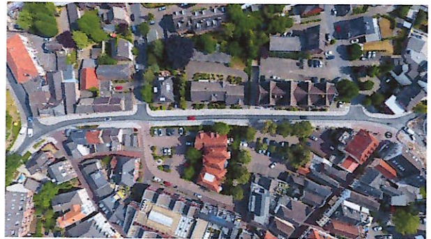
Abbildung 8 Südwall nach der Baumaßnahme; (Quelle: https://www.straelen.de/bauen-wirtschaft/integriertes-hand-lungskonzept-straelen-2022/umbau-der-wallstrassen/ )
