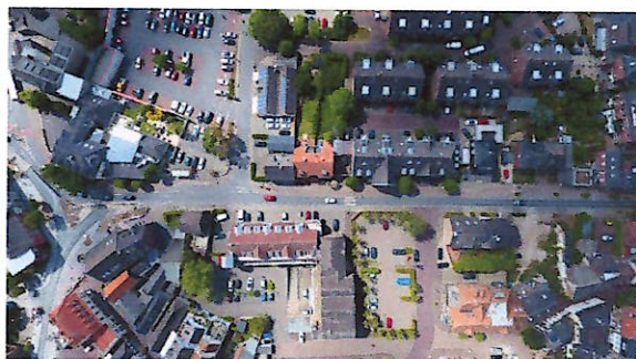
Abbildung 11 Westwall vor Baubeginn, Quelle: Stadt Straelen
