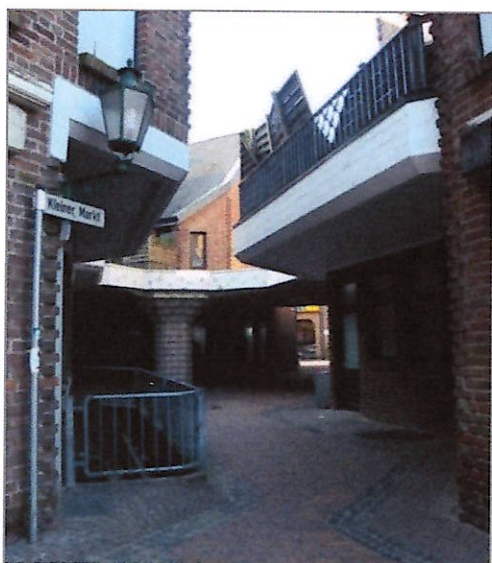
Abb. 2: Kleiner Markt vor dem Abriss des "Betonpilzes" (Quelle: DSK 2018)
