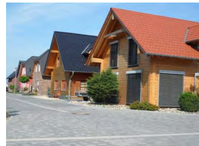
Foto 13 Neubaugebiet am Gieselberg
