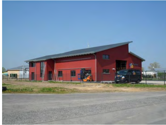
Foto 60 Betriebe im neuen Gewerbegebiet Hetzert
