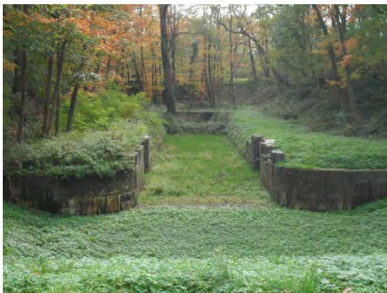
Foto 53 ehemalige Schleuse Nordkanal
