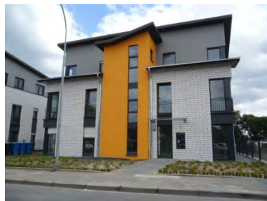
Foto 9 Neubau an der Beethovenstraße
