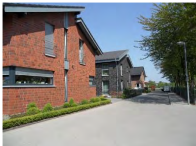
Foto 11 Neubaugebiet am Glasweg
